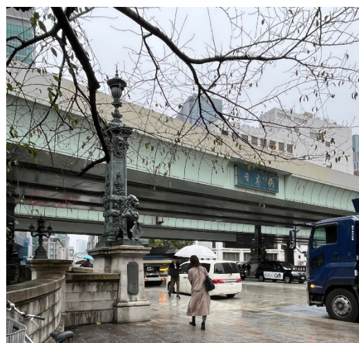
首都高速の橋脚に掲げられた「日本橋」の額。文字の揮毫は第15代将軍 徳川慶喜公による。
